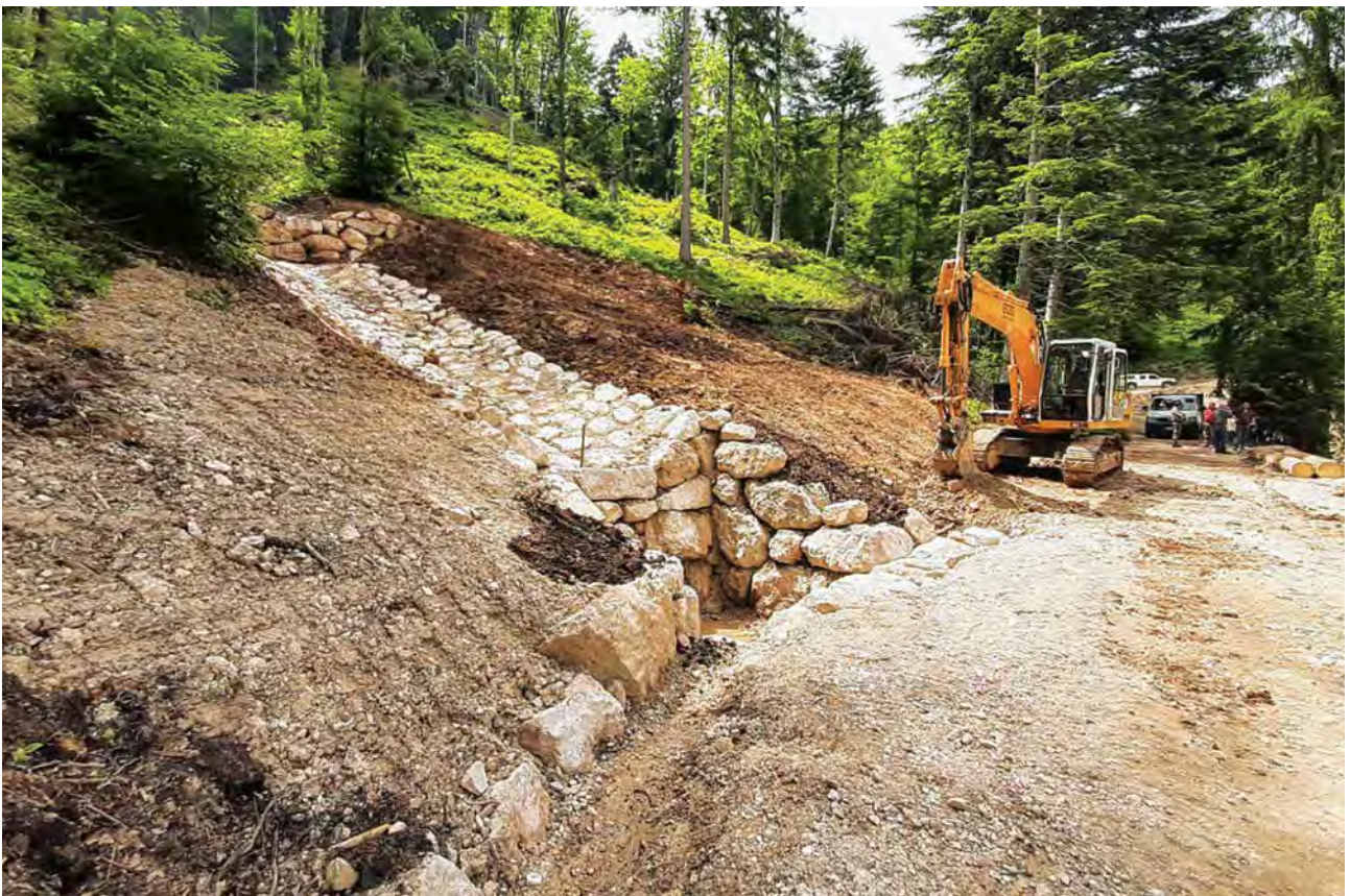
FOTO 3.8 - 3.9 - Sequenza di lavori di ripristino realizzati nel territorio di competenza dell'UDF Pergine Valsugana
