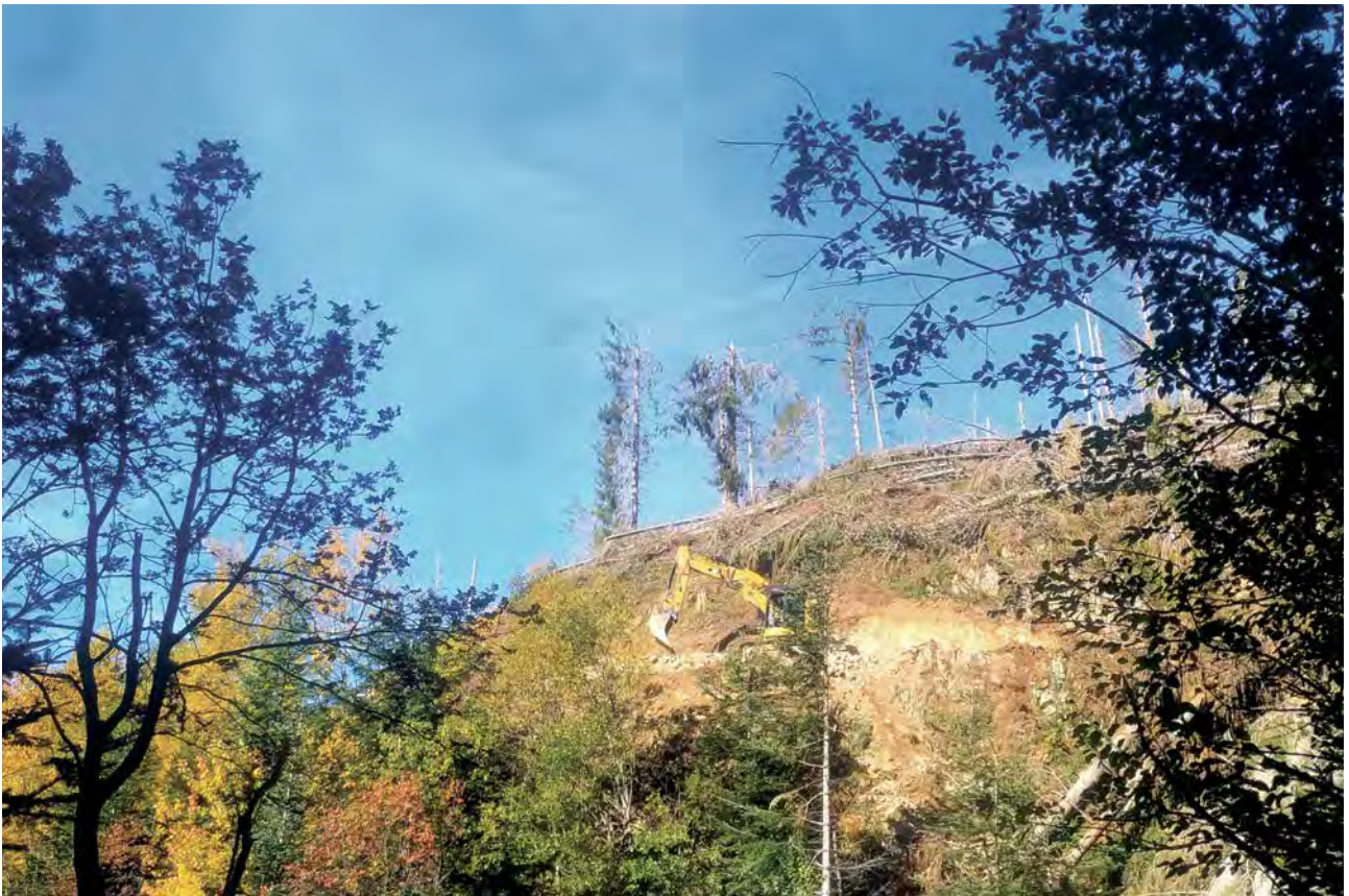
FOTO 3.17 - Realizzazione di una nuova strada forestale in area colpita da Vaia nell'UDF di Pergine Valsugana
