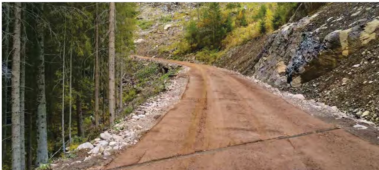
FOTO 4.7 - Costruzione di nuova strada forestale da parte della Magnifica Comunità di Fiemme
