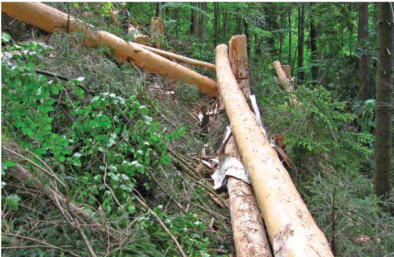
FOTO 6.7 - Tronchi disposti orizzontalmente per creare ostacoli naturali a fenomeni come la caduta massi
