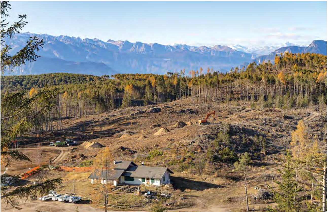
FOTO 7.13 - 7.14 - Lavori di rimodellazione delle superfici
