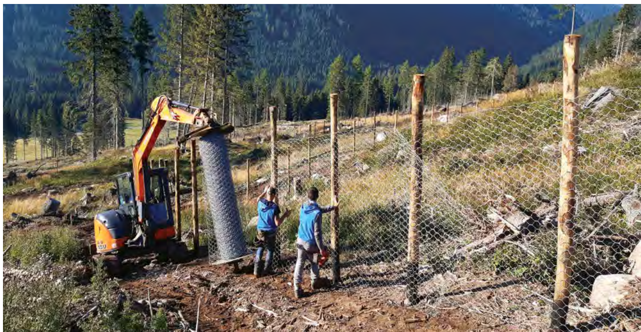
FOTO 8.3 - Realizzazione di una recinzione di protezione delle piantine a Paneveggio
