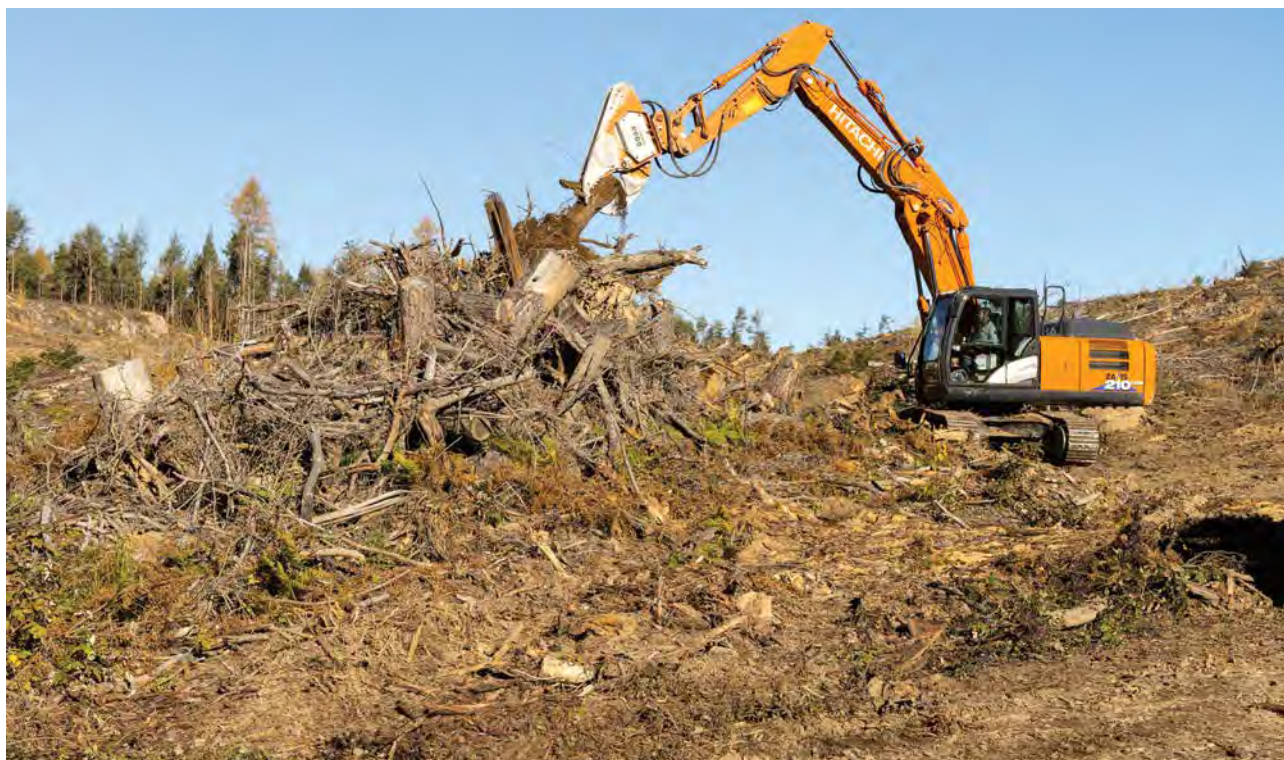
FOTO 7.12 - Lavori di rimozione delle ceppaie
