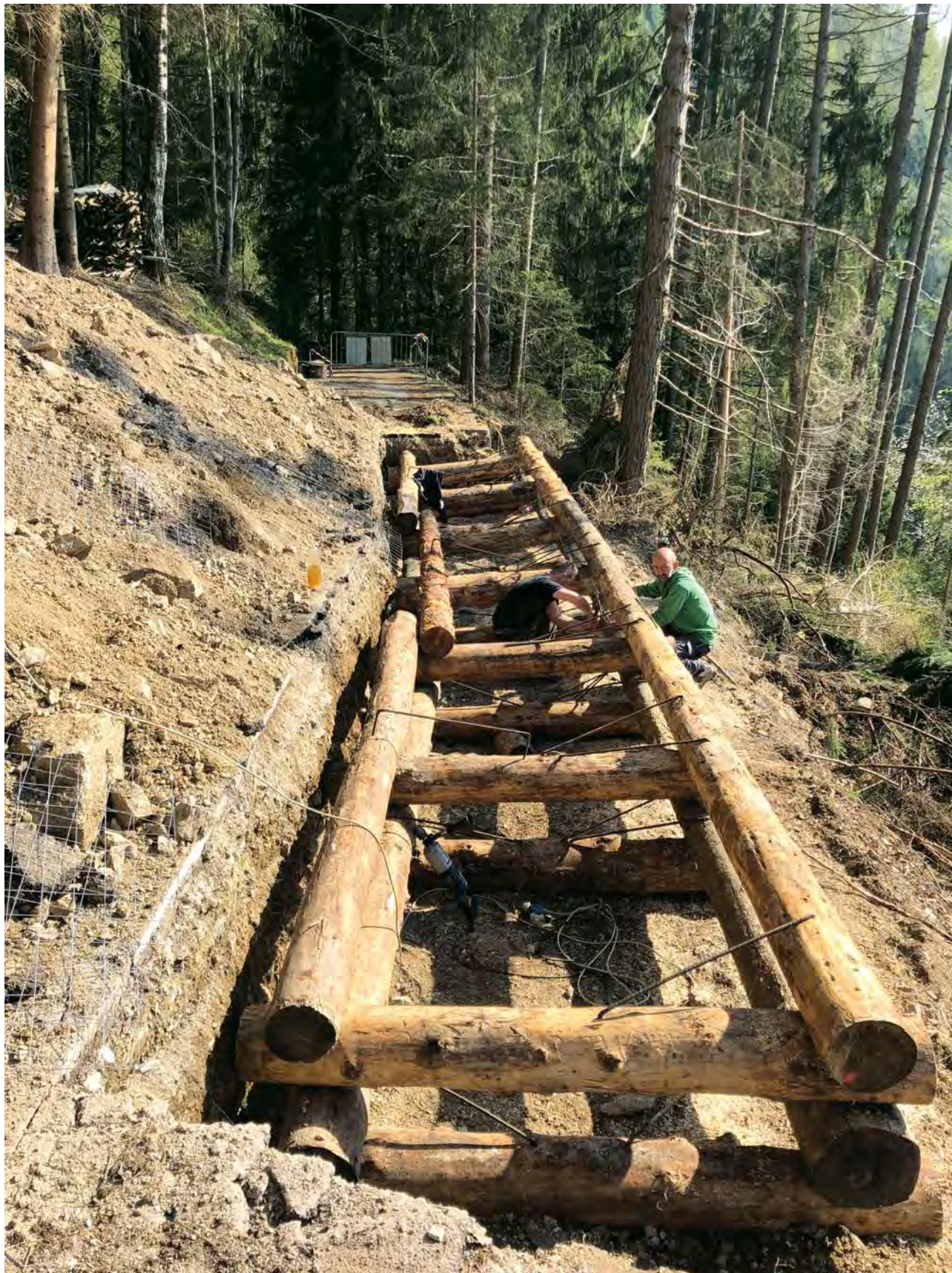
FOTO 3.6 - Ripristino di un tratto di strada forestale nell'UDF di Primiero
