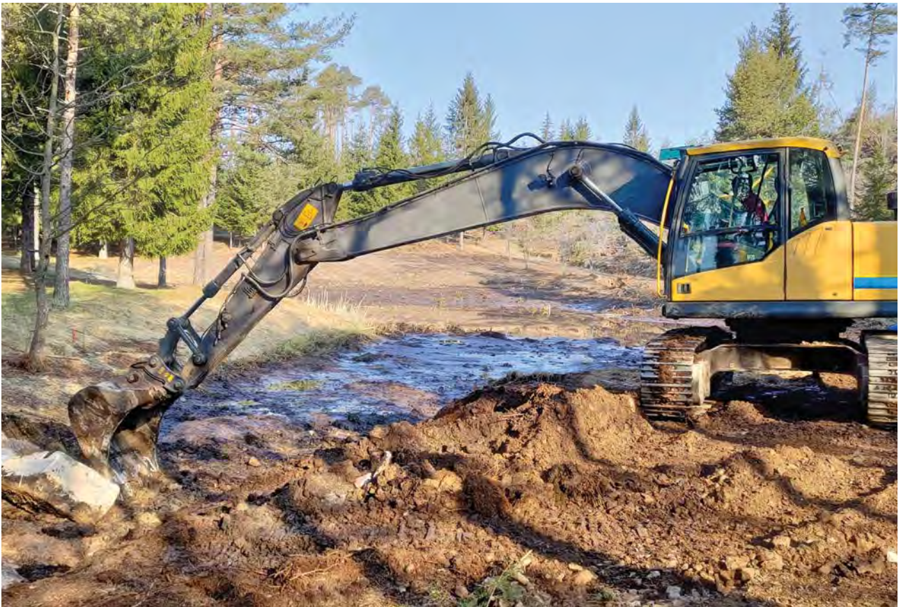
FOTO 7.25 - 7.26 - Lavori realizzazione soglia in massi e ripristino del corso d'acqua in uscita del laghetto delle Rane
