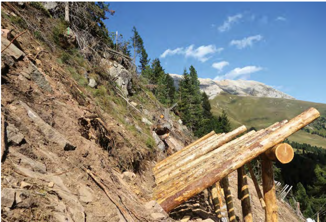
FOTO 7.31 - 7.32 - Lavori di realizzazione di paravalanghe nell'area campione "Pampeago"
