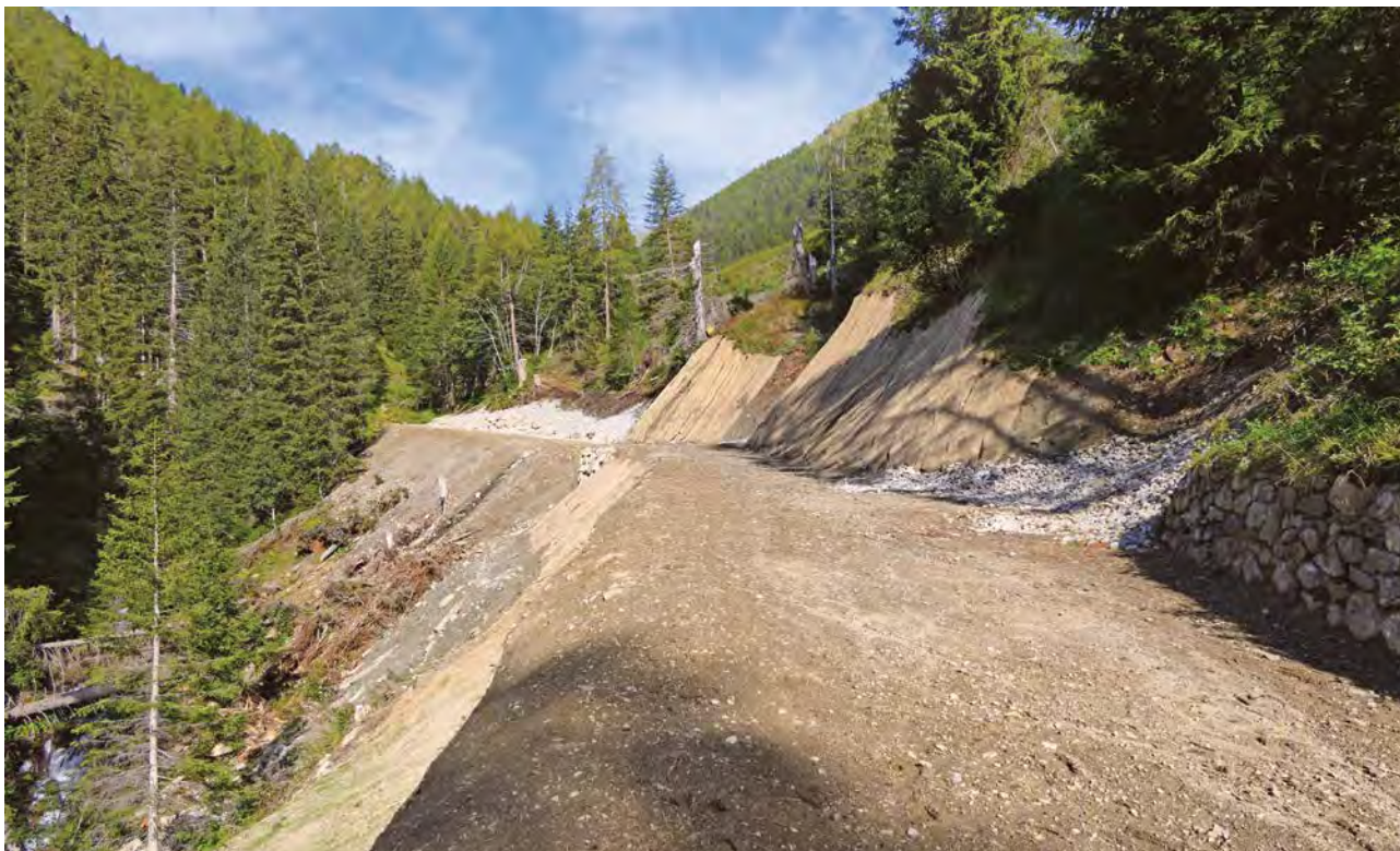
FOTO 3.14 - Ripristino e adeguamento di strada forestale nell'UDF di Malè
