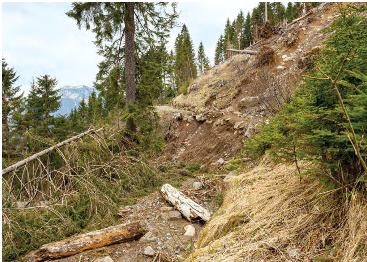
FOTO 3.3 - Strada forestale interrotta a causa di uno smottamento
