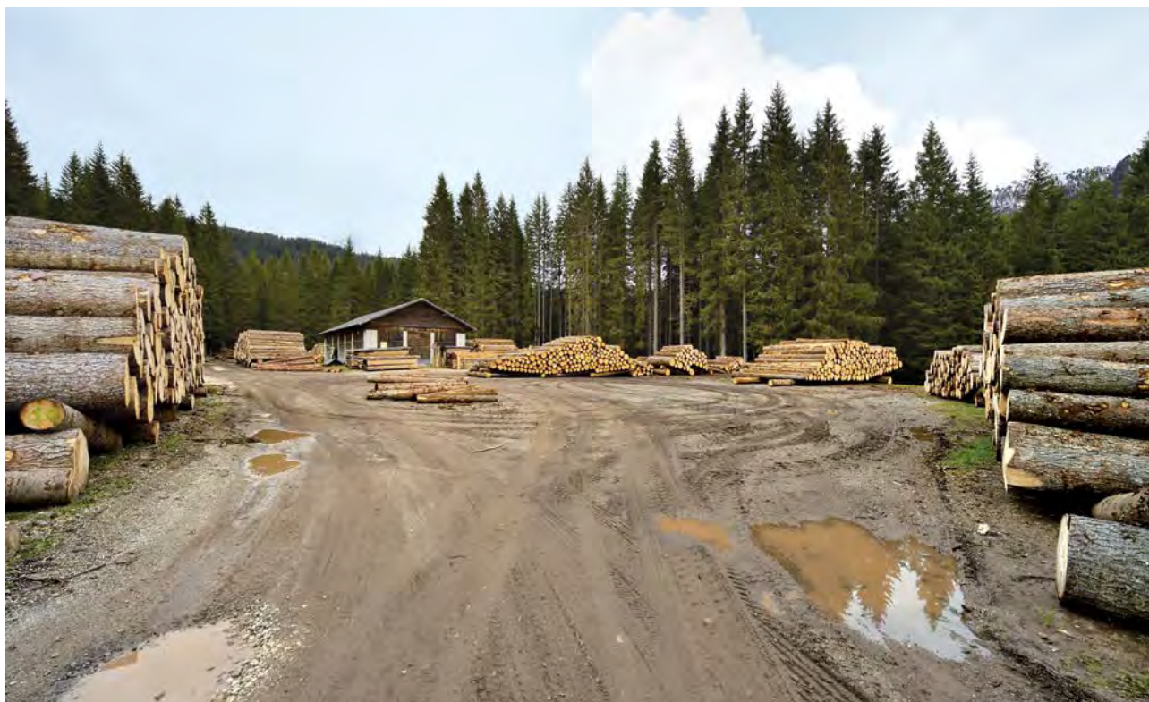
FOTO 3.33 - Adeguamento di un piazzale nei pressi della Stazione forestale di Paneveggio
