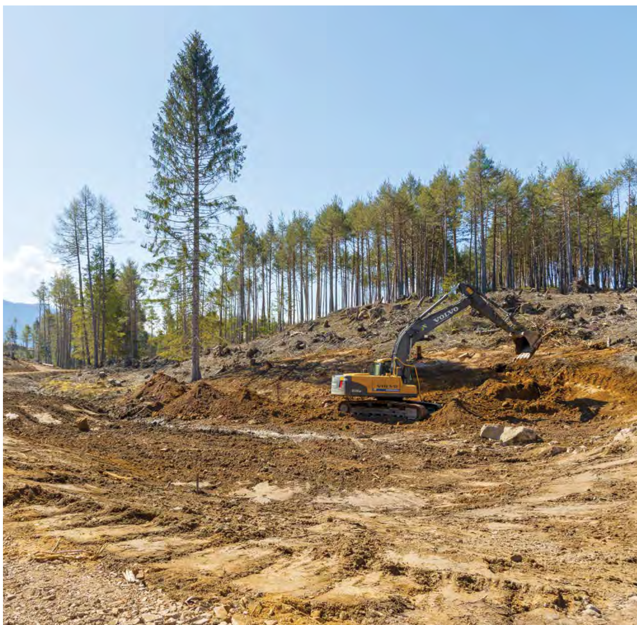
FOTO 7.22 - Rimozione delle ceppaie nella zona in prossimità del laghetto delle Rane
