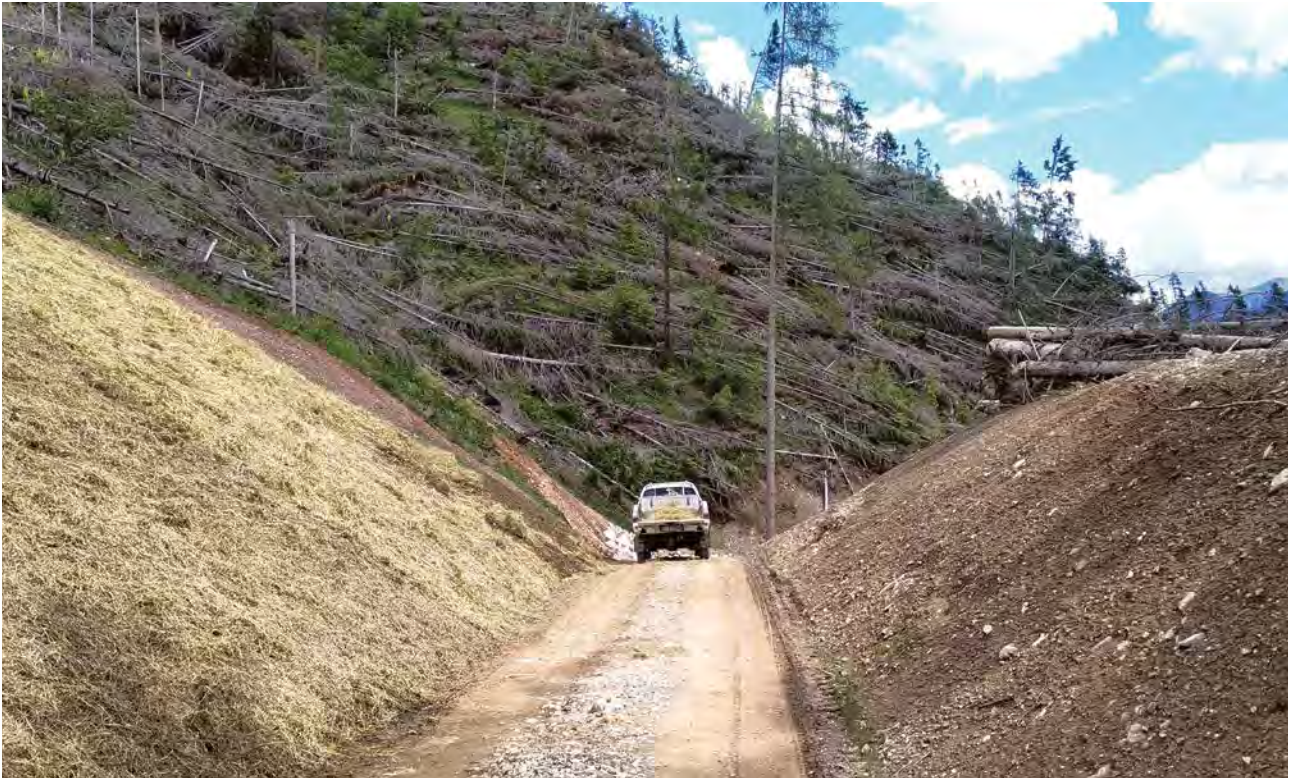
FOTO 3.16 - Realizzazione di una nuova strada forestale in area colpita da Vaia nell'UDF di Cavalese
