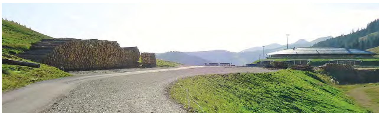
FOTO 3.25 - Adeguamento di un piazzale esistente in loc. Marande nel Comune di Castello Tesino
