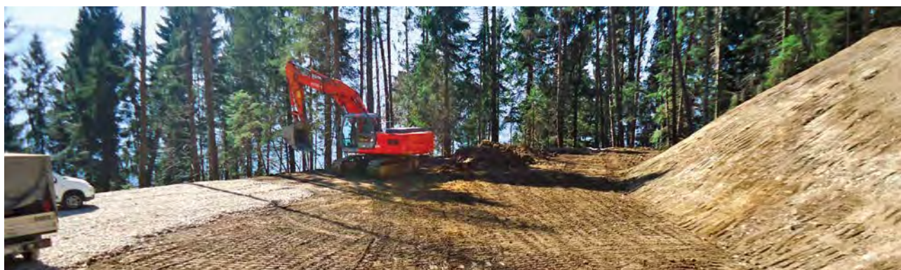
FOTO 3.26 - Realizzazione di un nuovo piazzale locale in loc. Desene nel Comune di Ronchi Valsugana
