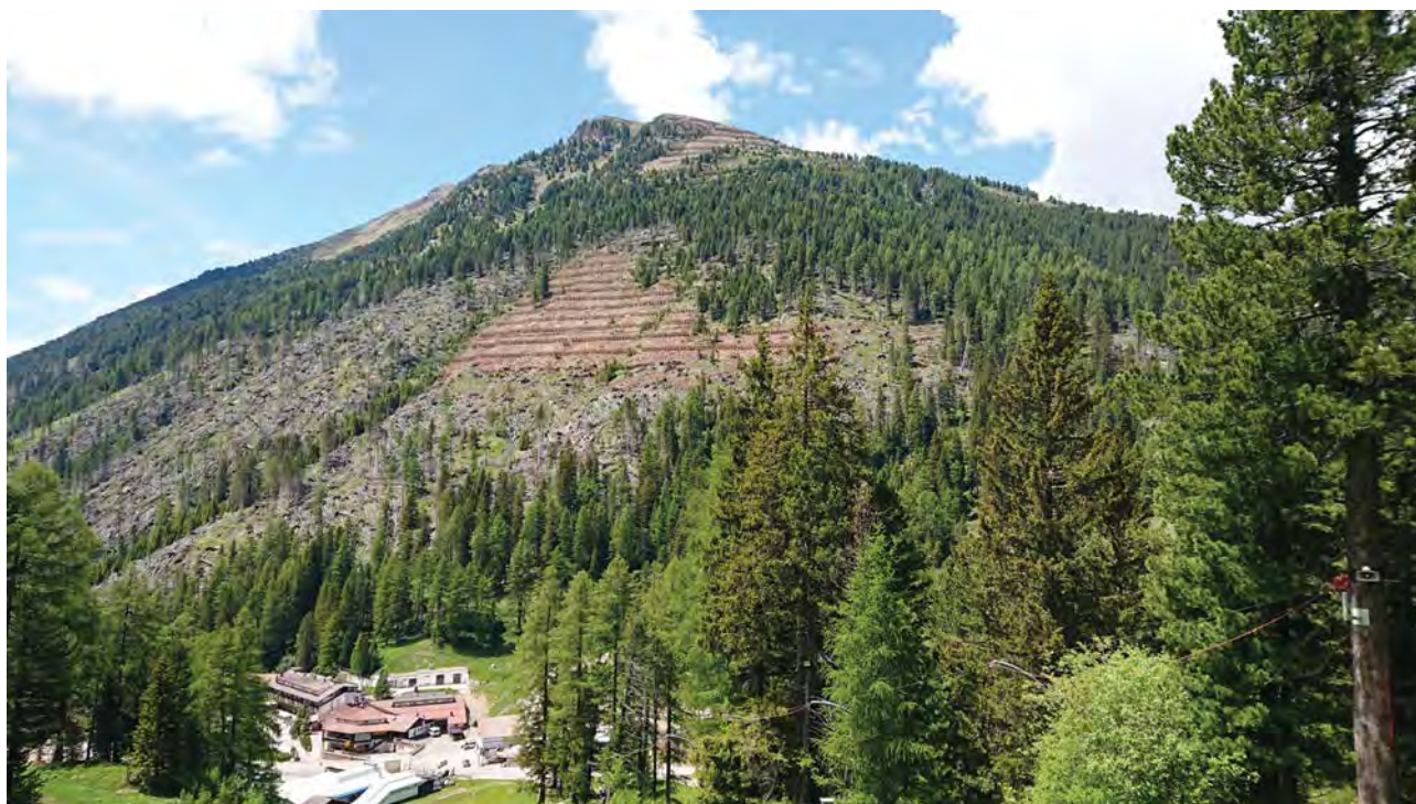
FOTO 2.14 - Paravalanghe realizzati a monte dell'abitato di Pampeago. In attesa di realizzare ulteriori strutture è stato lasciato il materiale schiantato a terra al fine di aumentare la funzione di protezione
