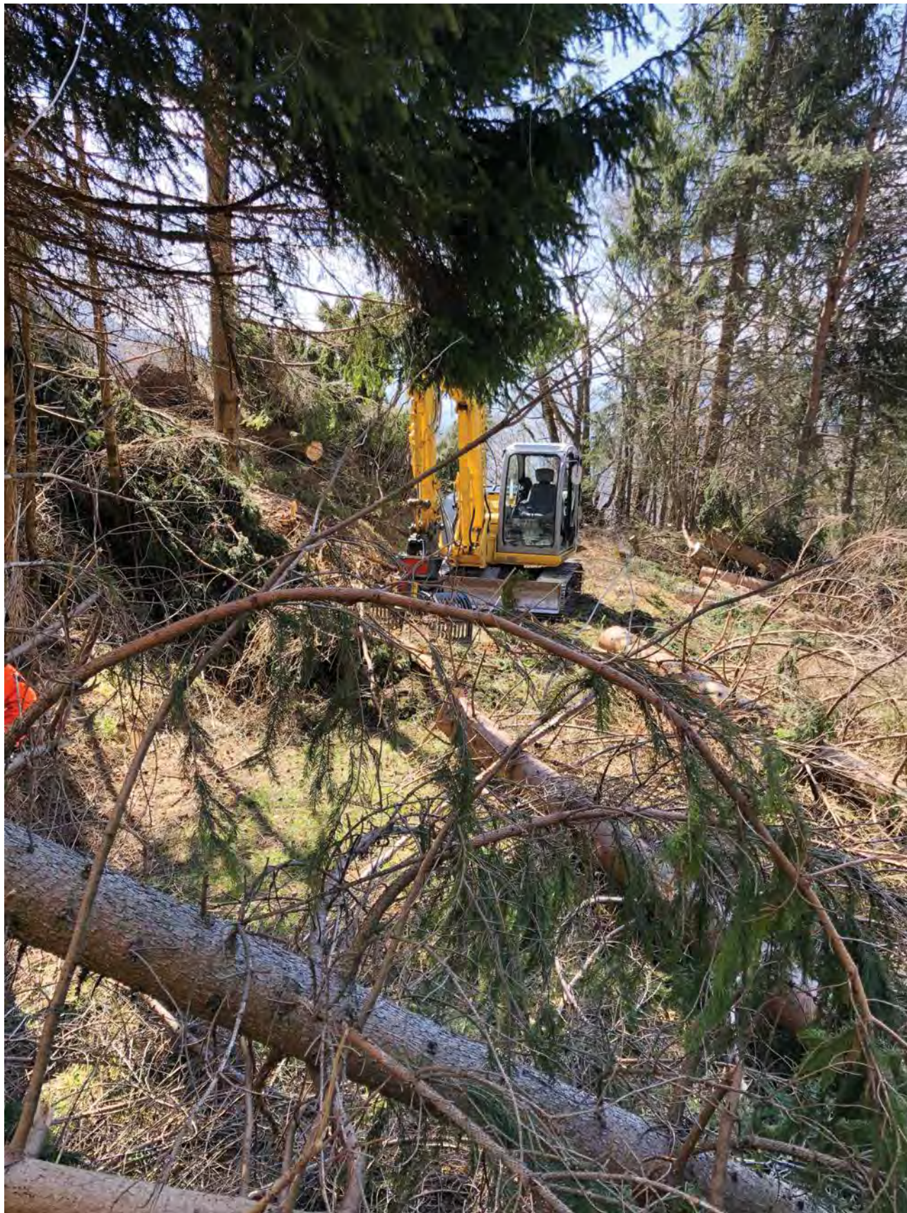
FOTO 3.7 - Sgombero dagli schianti e ripristino di strada forestale nell'UDF di Primiero
