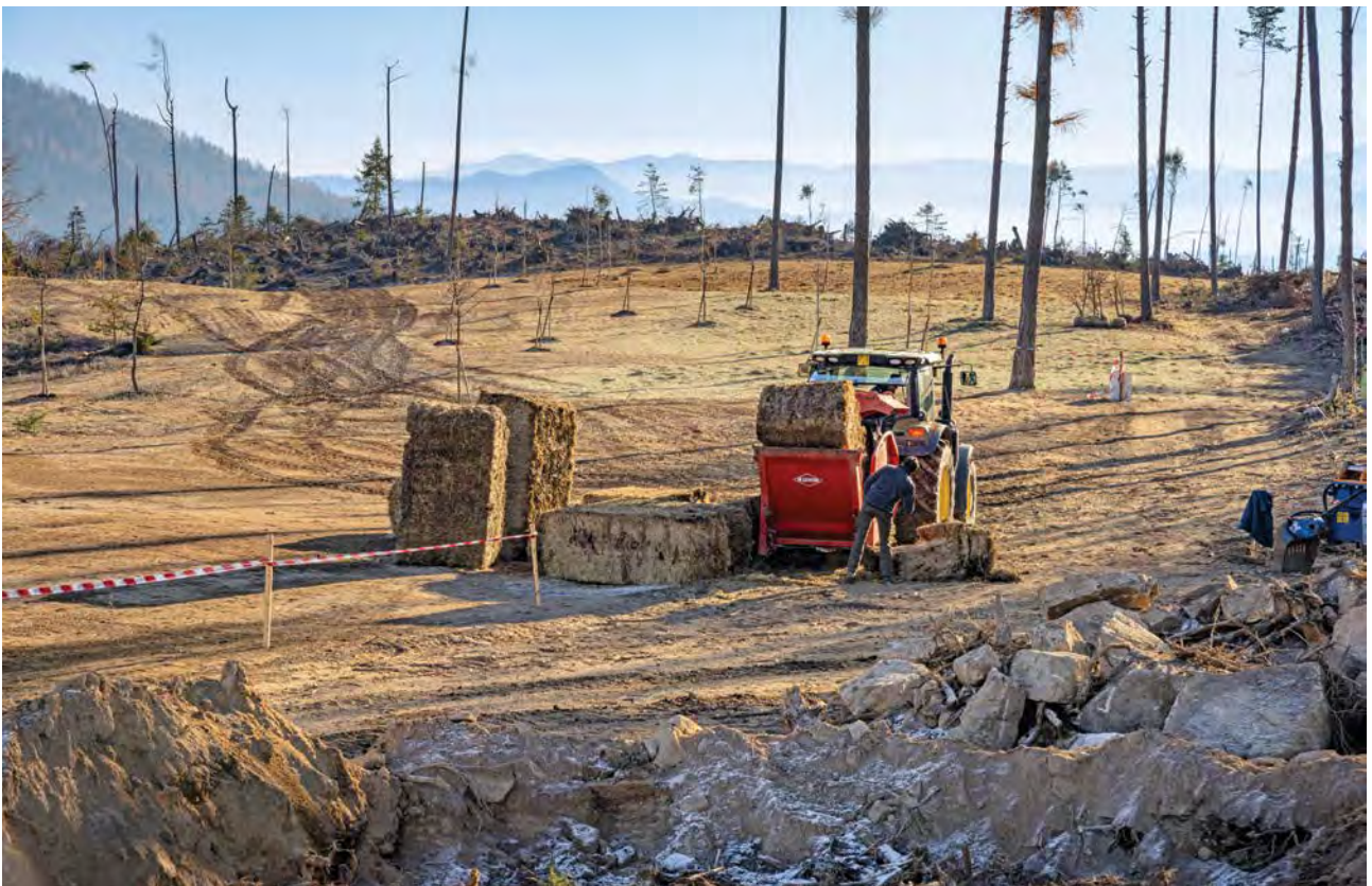
FOTO 7.17 - 7.18 - Semina di miscuglio per tappeto erboso protetto con strato di fieno locale
