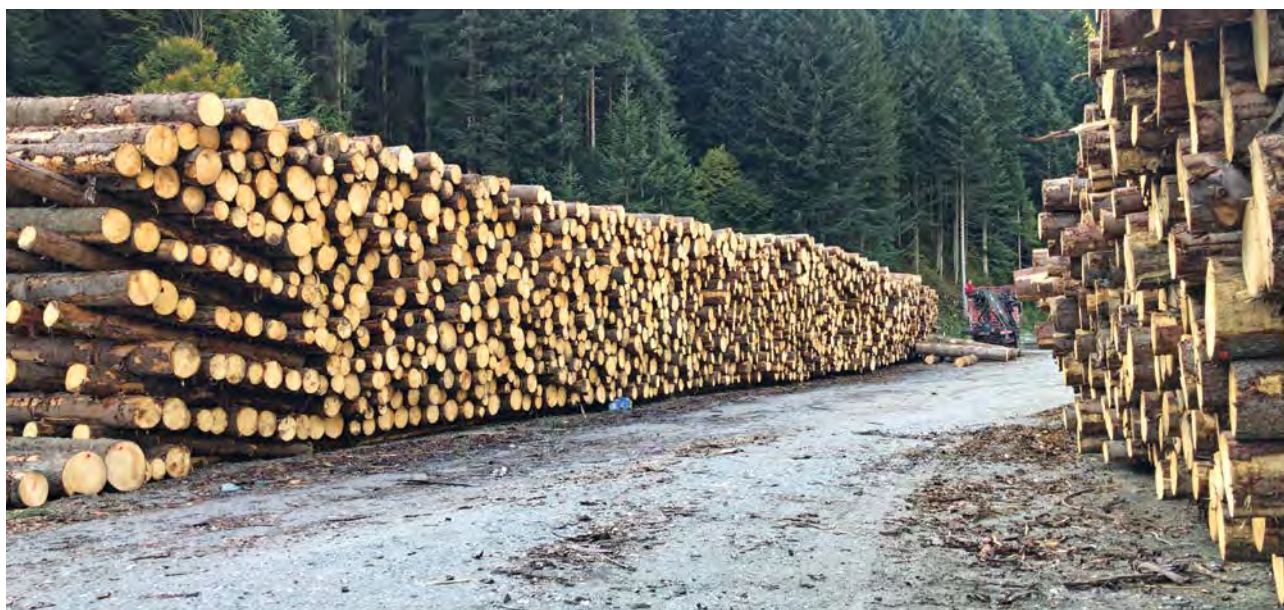
FOTO 3.28 - Adeguamento di un piazzale strategico in loc. Refavaie nel Comune di Cinte Tesino
