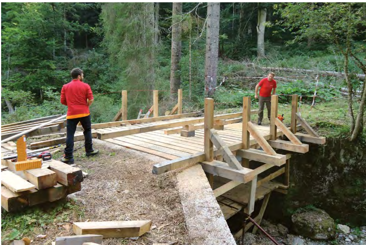
FOTO 3.10 - 3.11 - Lavori di ripristino realizzati nel territorio di competenza dell'UDF Borgo Valsugana
